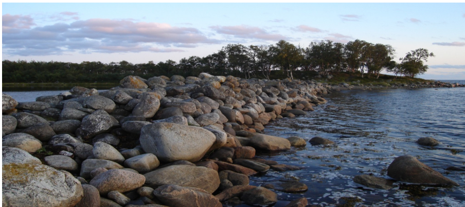
«Филипповы садки» - одно из изобретений Филиппа. Представляют собой систему огороженных участков мелководья с регулируемым стоком. Действие приливов и отливов используется в них для ловли рыбы.
